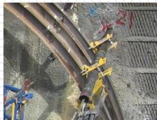
約40mの鋼管打設において、概ね1/200の高い打設精度の確保に成功しました。
