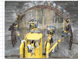
トンネル掘削で使用されるドリルジャンボを使用してφ139.8鋼管の超長尺打設が可能であり、専用の削孔機・人員を必要としません。
